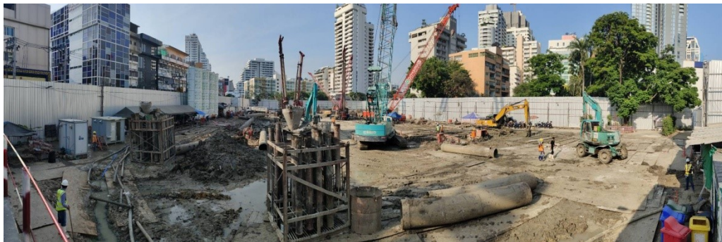
ภาพที่ 5-8 การก่อสร้าง Diaphragm Wall
