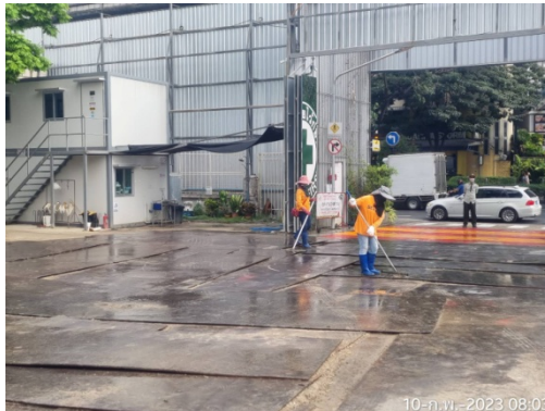
ภาพที่ 5-12 ฉีดล้างล้อรถบรรทุกด้วยเครื่องฉีดน้ำแรงดันสูง และปิดคลุมท้ายกระบะบรรทุกก่อนออกจากโครงการ
