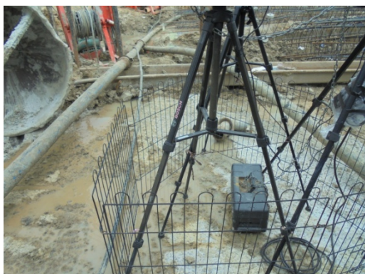
ภาพที่ 6 การติดตั้งเครื่องตรวจวัดคุณภาพสิ่งแวดล้อม และเก็บตัวอย่างน้ำทิ้ง (บริเวณด้านทิศตะวันตก และเครื่องตรวจวัดความสั่นสะเทือนขยับไปตามทิศทางการทำเสาเข็ม)
