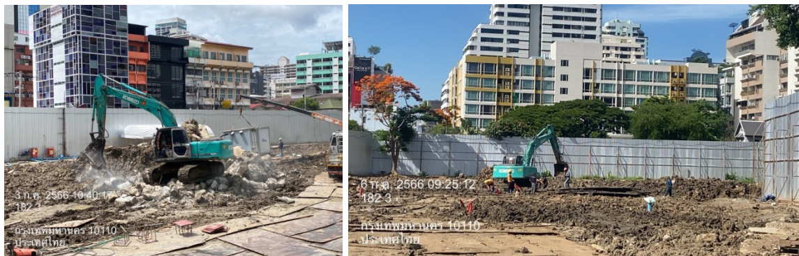
ภาพที่ 5-47 ปรับพื้นที่ให้เรียบ ขนเศษวัสดุและหินออก และปรับดินให้เสมอตลอดทั้งพื้นที่โครงการหลังจากการก่อสร้าง Capping Beam แล้ว เสร็จ และหลังจากนี้ทางโครงการจะดำเนินการหยุดการก่อสร้าง
