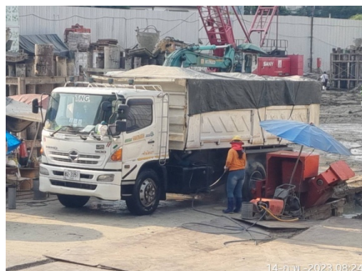
ภาพที่ 5-12 ฉีดล้างล้อรถบรรทุกด้วยเครื่องฉีดน้ำแรงดันสูง และปิดคลุมท้ายกระบะบรรทุกก่อนออกจากโครงการ
