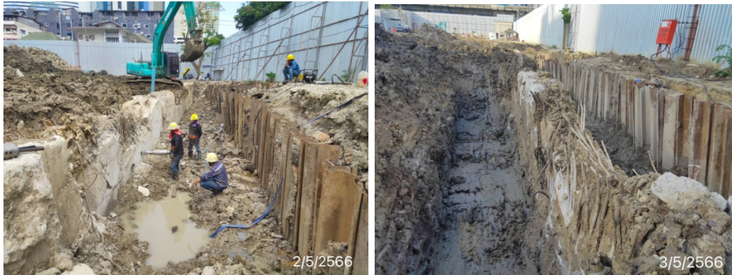
ภาพที่ 5-40 ติดตั้ง Sheet Pile ป้องกันดินพังทลาย
