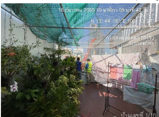
ติดตั้งตาข่ายกันฝุ่นสีเขียวคาดฟ้า บ้านเลขที่ 1/16
