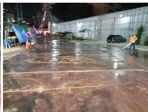
ภาพที่ 5-19 ล้างทำความสะอาดพื้นที่ก่อสร้างหลังเลิกงาน และปูพื้นด้วยแผ่นเหล็กหนา
