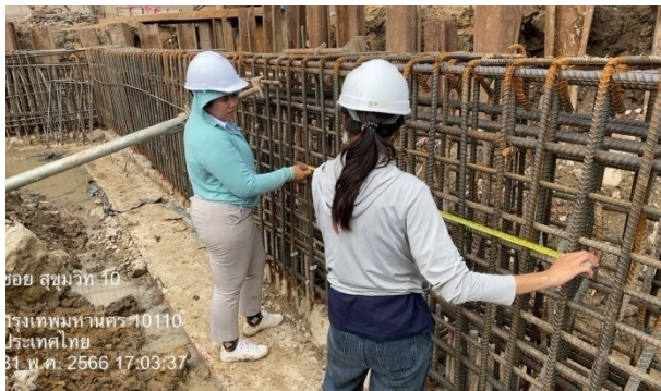
ภาพที่ 5-43 การก่อสร้าง Capping Beam และวิศวกรตรวจสอบการทำงาน
