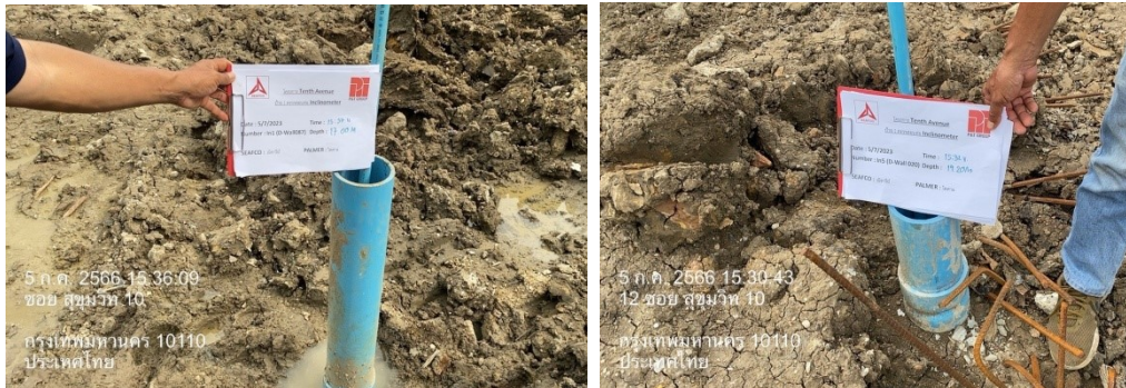
ภาพที่ 5-45 ติดตั้ง Inclinator ตรวจสอบการเคลื่อนตัวของดิน
