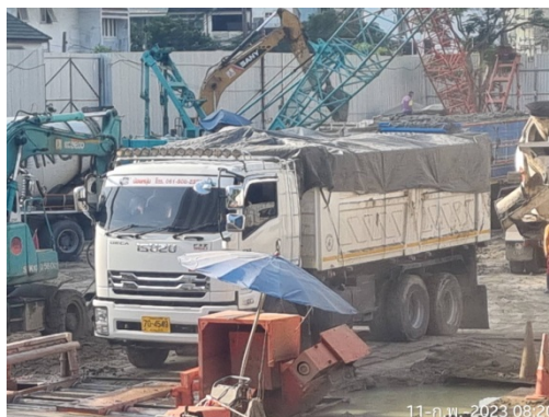
ภาพที่ 5-12 ฉีดล้างล้อรถบรรทุกด้วยเครื่องฉีดน้ำแรงดันสูง และปิดคลุมท้ายกระบะบรรทุกก่อนออกจากโครงการ
