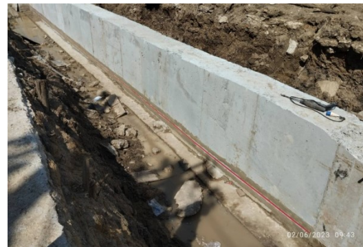
ภาพที่ 5-43 การก่อสร้าง Capping Beam และวิศวกรตรวจสอบการทำงาน
